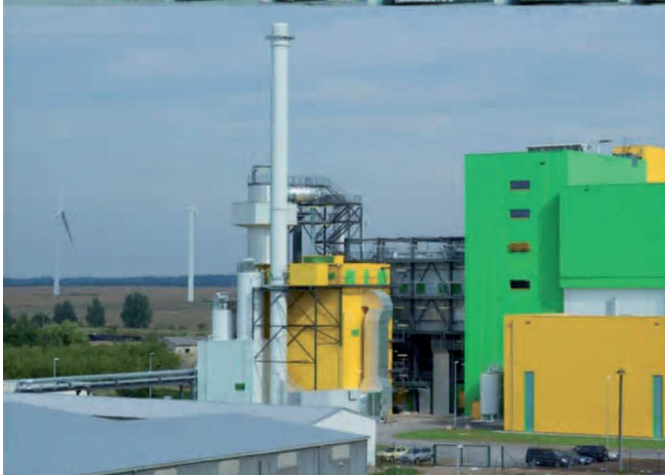
Limpeza de Gases
