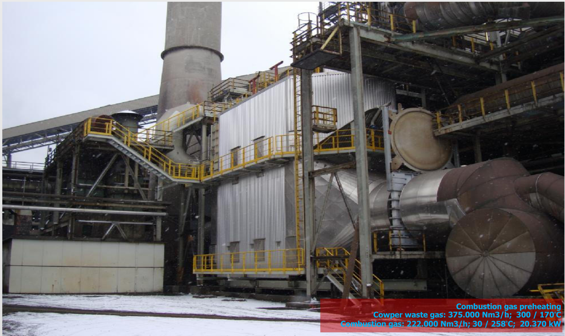
Ecostat-Heat-Pipe-System – Rogesa, Dilinger Stahlwerke, BF 5
