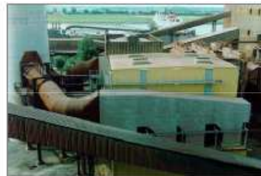
Área de filtração aprox.11.000 m 2
